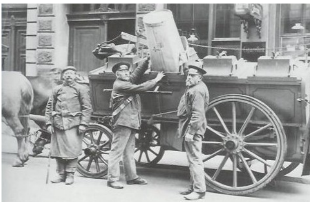
Tonnenumleersystem Colonia Magdeburg 1910
