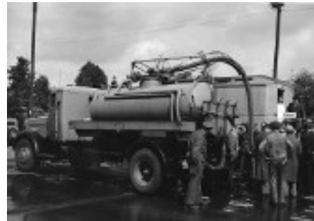
Vorführung zur Gullyreinigung 1957
